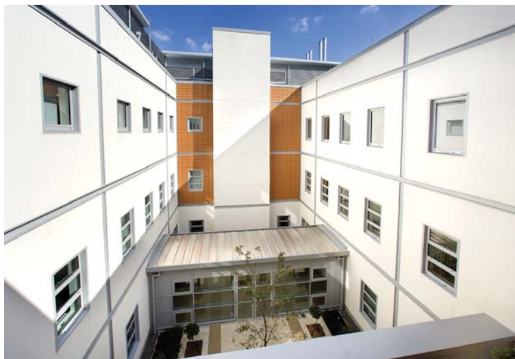
Modułowy system zabudowy przyspiesza proces projektowania i wykonawstwa. Halton Hospital (Independent Sector Treatment Centre)
